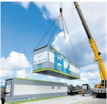
Die Elektrolyse-Anlagen der Fest GmbH werden in Containern montiert und wiegen bis zu 40 Tonnen.
