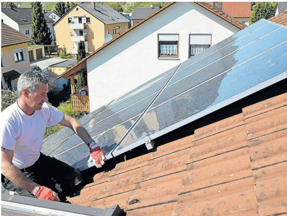
Der qualifizierte Dachdecker prüft die Befestigungen der Solarmodule und begutachtet die Unterkonstruktion beim DachCheck. Foto:akz-o
