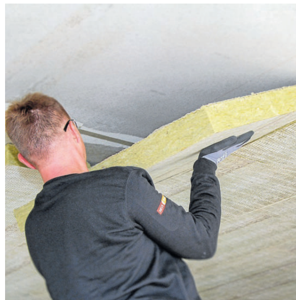
Die Kellerdecke gehört zu den am einfachsten realisierbaren Dämmmaßnahmen im und am Haus. Foto: Heck Wall Systems
