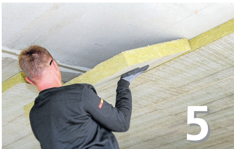
Das Dämmen der Kellerdecke birgt Energiesparpotenzial.
