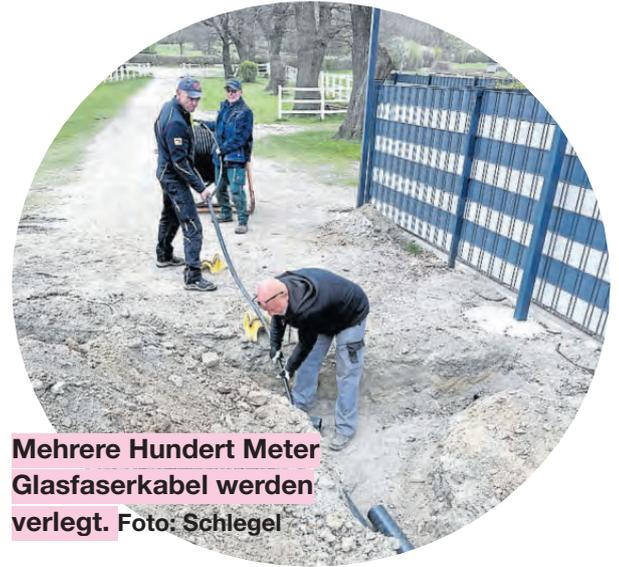
**Mehrere Hundert Meter Glasfaserkabel werden verlegt. Foto: Schlegel**
