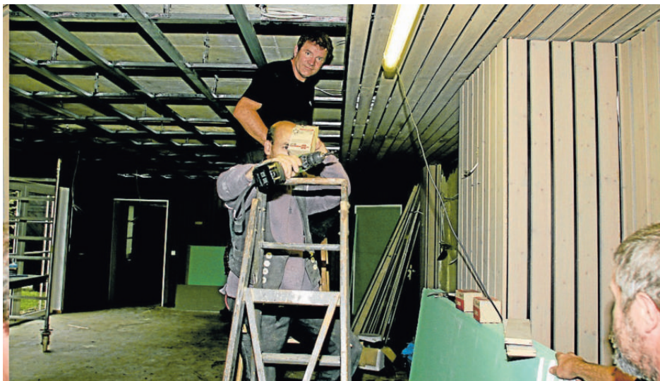
2013 wurde der Wellnessbereich großflächig umgebaut.
